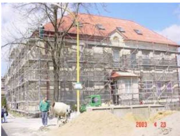
Oprava ZŠ v roce 2003
